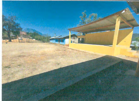
Foto 2: MEJORAMIENTO MODULO 5 (ESCENARIO), ESTRUCTURA DE TECHO
