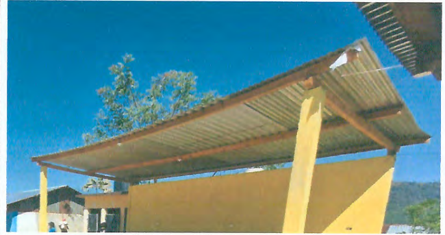
Foto 2: MEJORAMIENTO MODULO 5 (ESCENARIO), CUBIERTA DE LAMINA
