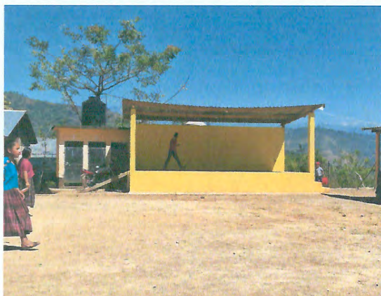
Foto 3: MEJORAMIENTO MODULO 5 (ESCENARIO), ESTRUCTURA DE TECHO
