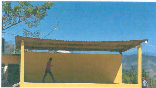
Foto 1: MEJORAMIENTO MODULO 5 (ESCENARIO), CUBIERTA DE LAMINA
