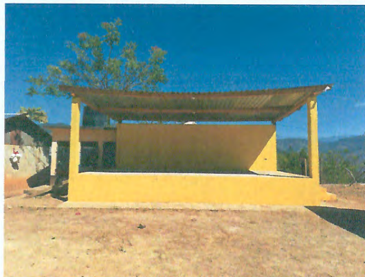
Foto 1: MEJORAMIENTO MODULO 5 (ESCENARIO), ESTRUCTURA DE TECHO
