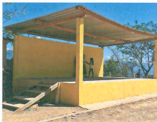
Foto 4: MEJORAMIENTO MODULO 5 (ESCENARIO), ESTRUCTURA DE TECHO
